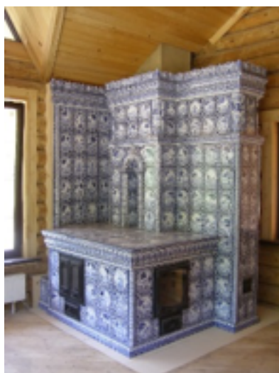
Рисунок 9 – Изразцовая дровяная печь для обогрева и приготовления пищи с лежанкой. Майкоп.
