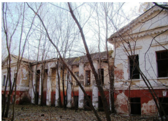
Рисунок 10 – Лоджия-галерея в усадьбе Денежниково, начало XIX в. Figure 10 – Loggia Gallery in the Denezhnikovo Manor, beginning of the 19 th century
