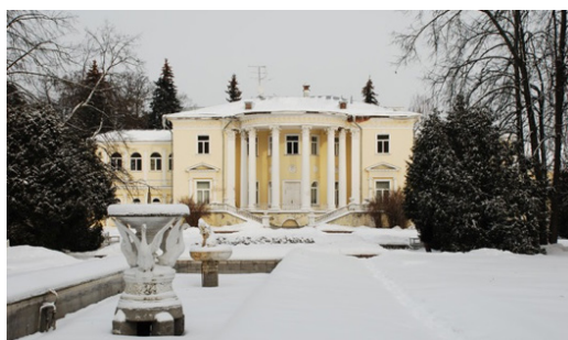
Рисунок 13 – Парковый фасад усадьбы Введенское, в 1912 г. перестроен в кирпиче Figure 13 – Park facade of the estate Vvedenskoe, in 1912 rebuilt in brick
