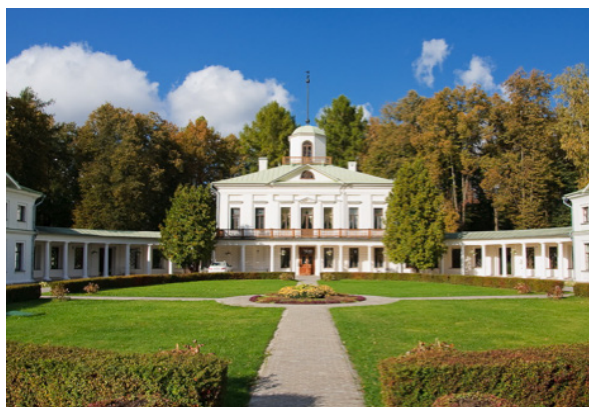
Рисунок 9 – Крытые колоннады в усадьбе Середниково, конец XVIII в. Figure 9 – Covered colonnades in the estate Serednikovo, the end of the 18 th century
