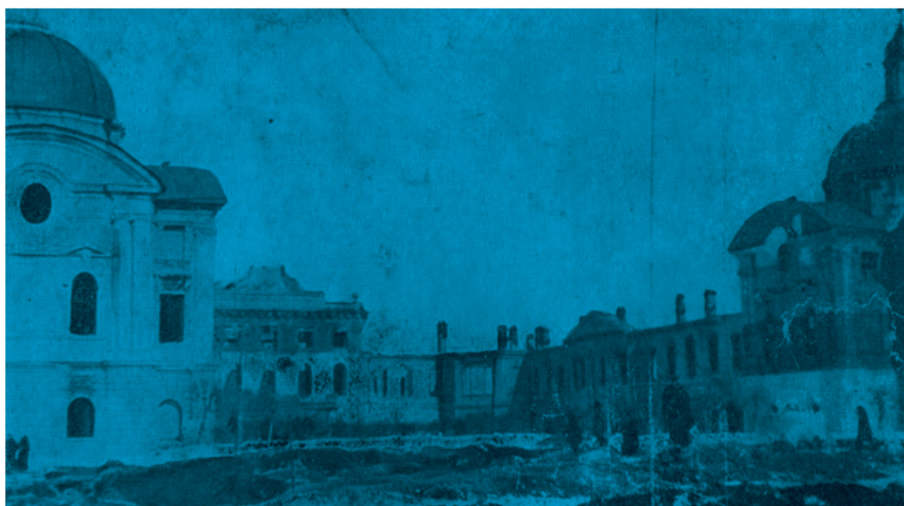
Иллюстрация 21 — Калинин (Тверь). Здание Облисполкома (быв. Императорский путевой дворец). Фото Н. Виноградова. Март 1942 г. [4, с. 42] Figure 21 — Kalinin (Tver). The Building of the Regional Executive Committee (Formerly the Imperial Travel Palace). Photo by N. Vinogradov. March 1942 [4, p. 42]
